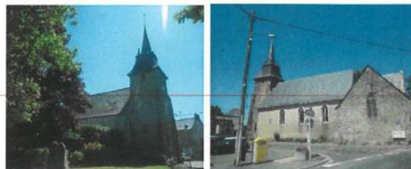
Façade Nord, à gauche et façade Sud, à droite
