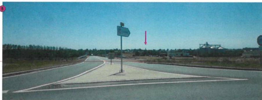
Au-delà du vallon du ruisseau de la Chauvinière, à hauteur de l'accès à la RD57 (route d'Argentré), le clocher est perceptible, mais les enjeux semblent moindres au vu de l'environnement très perturbé de cette frange septentrionale du bourg (2x2 voies, ligne LGV, silos agricoles de la zone d'activités de la Chauvinière... Le vallon arboré du ruisseau de la Chauvinière se perçoit cependant assez nettement dans le paysage
