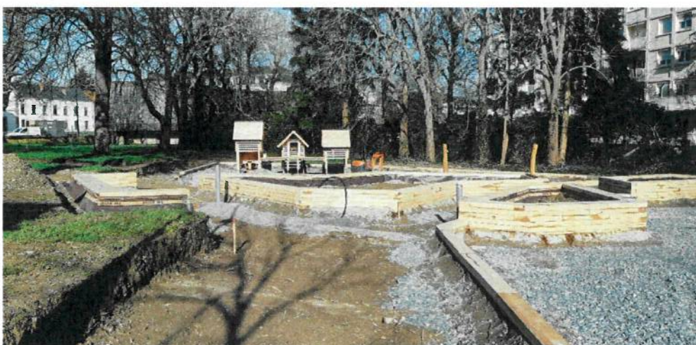
L'aire de jeux en cours d'aménagement
