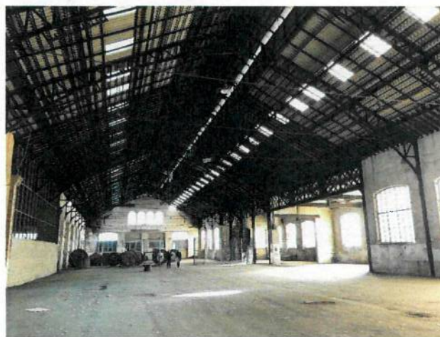
Figure 8 - Intérieur de la Hall SNCF
