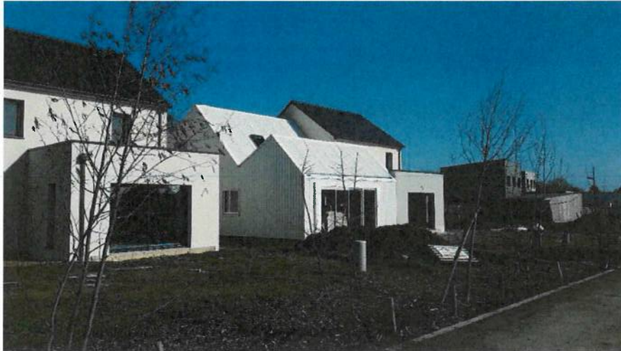
Chantiers livrés au Hameau de la Fuye (flots G7 a et c)
