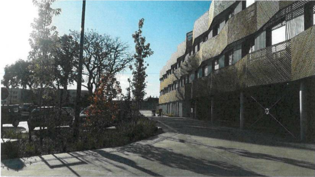
Aménagement des abords de l'EHPAD
