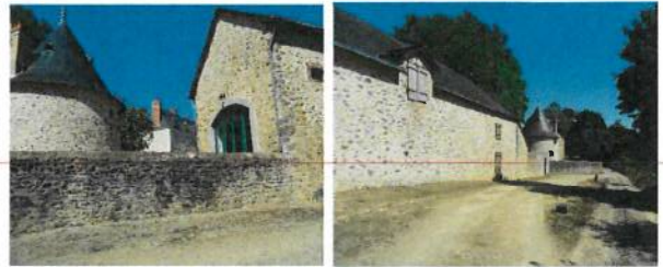
Murs Ouest avec la fuye
