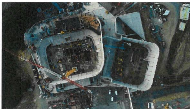
Chantier d'Espace Mayenne
