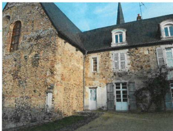
Partie du mur méridional et ancien presbytère
