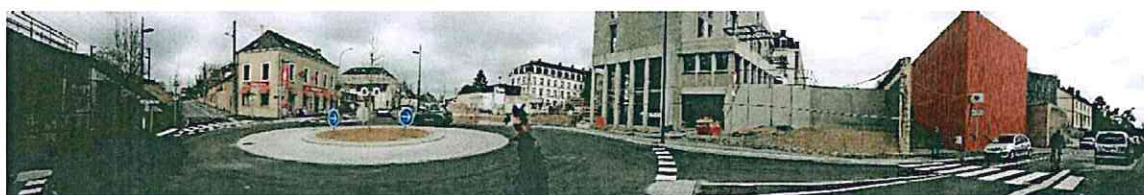
Création du giratoire à l'angle de l'avenue de Fougères et de la rue de la Gaucherie
