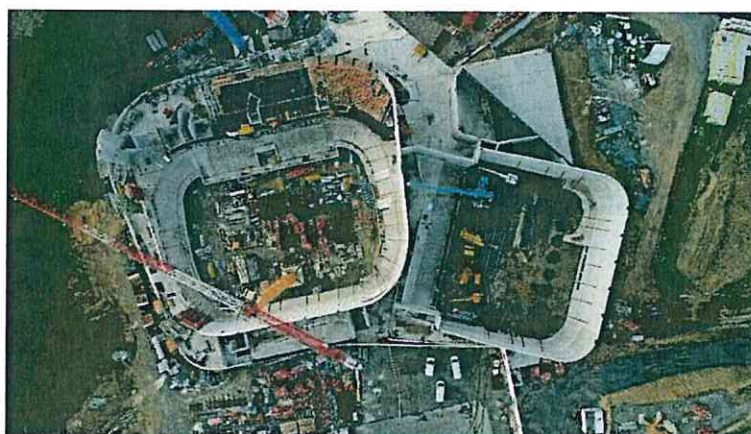
Chantier d'Espace Mayenne
