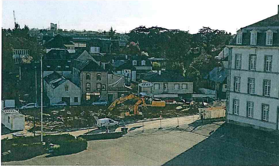
Déconstruction du bâtiment 58 et du mur d'enceinte sis avenue de Fougères
