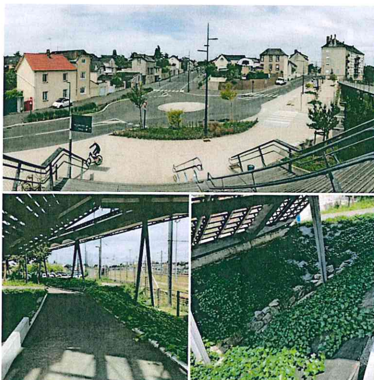
Figure 8 - Giratoire de Coubertin et aménagement paysager sous l'escalier de la passerelle
