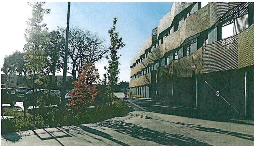
Aménagement des abords de l'EHPAD
