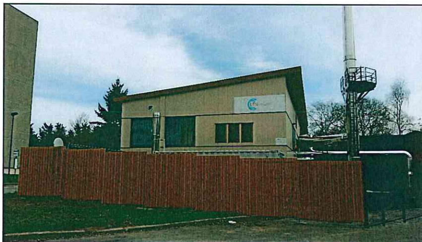
Photo de la chaufferie Ferrié après rénovation, avec à droite la sous-station d'échange
