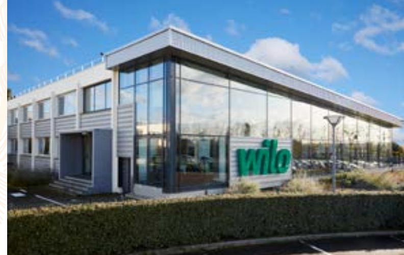
Crédit photo : Site de production Wilo France, Laval
