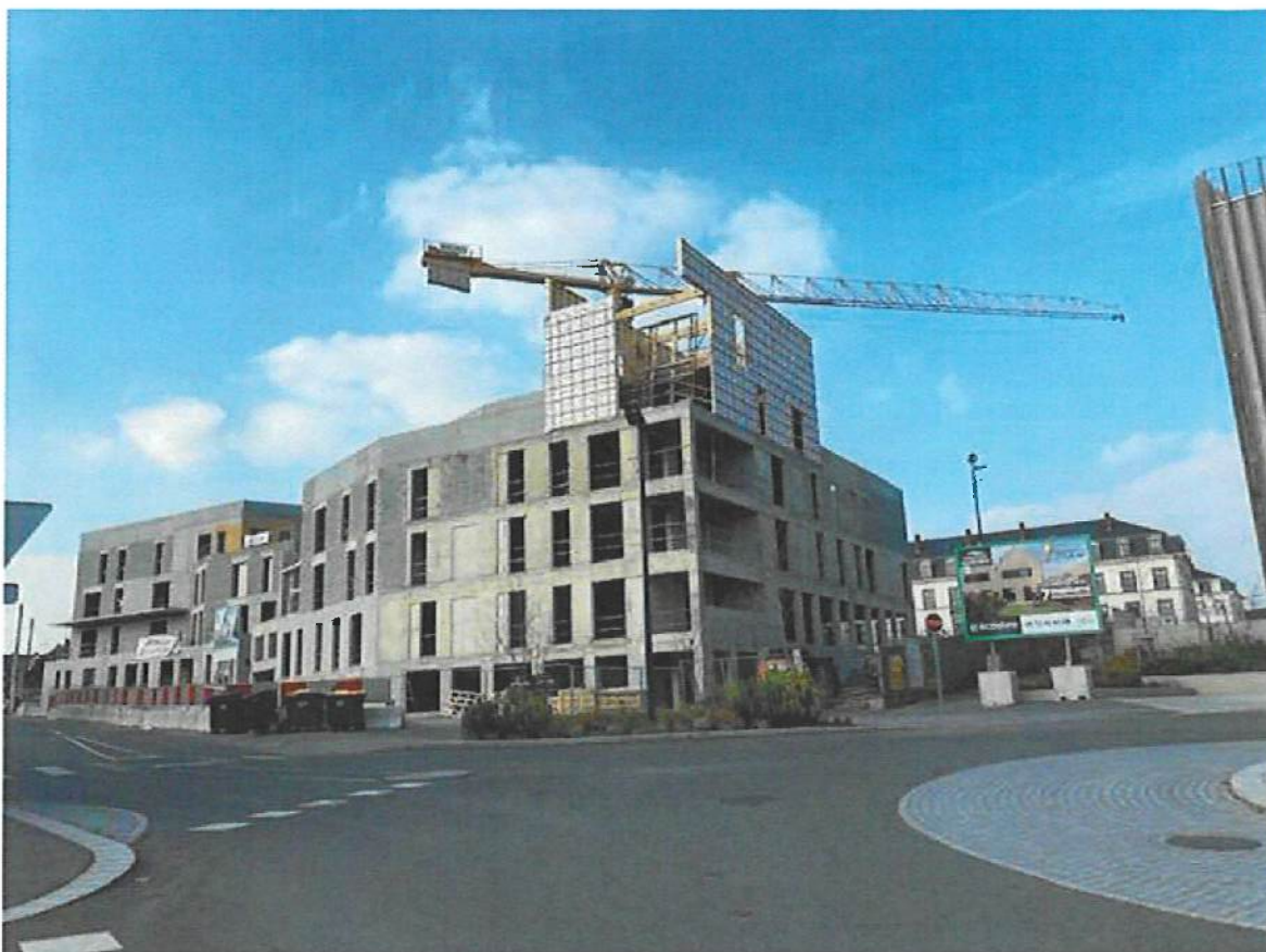
L'opération Chrysalide vue depuis l'avenue de Fougères
