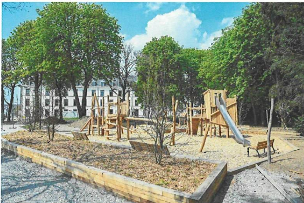
L'aire de jeux en cours d'aménagement (crédit : K. Rouschousse – Ville de Laval)
