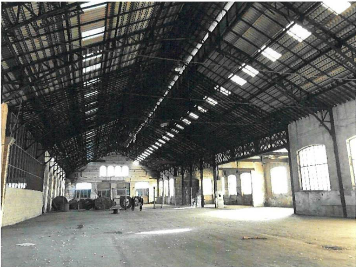
Figure 87 - Intérieur de la Halle SNCF
