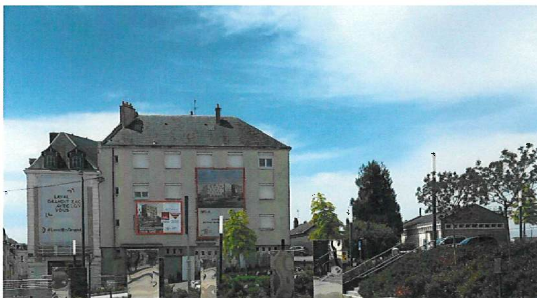
Figure 54 - Immeubles 20 et 22 place de la gare
