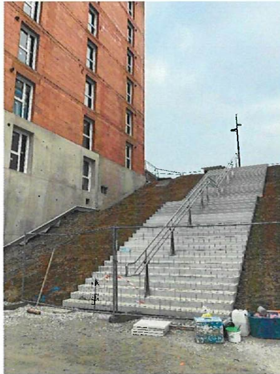
Figure 1342 - Aménagements des abords du lot 1C
