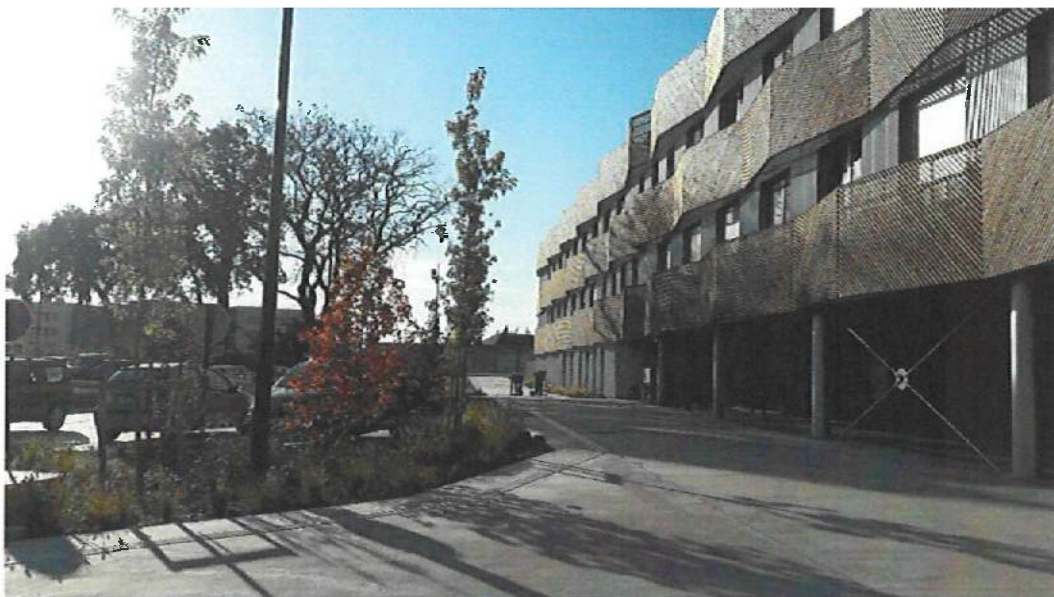
Aménagement des abords de l'EHPAD
