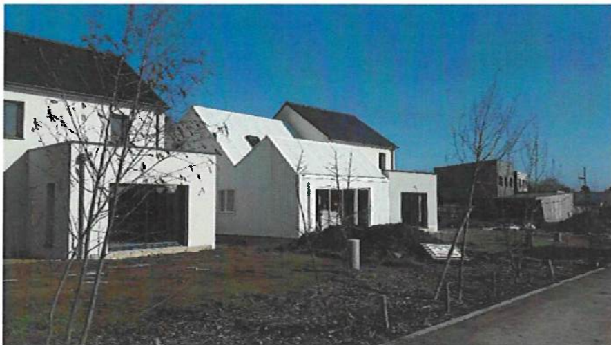
Chantiers livrés au Hameau de la Fuye (ilots G7 a et c)
