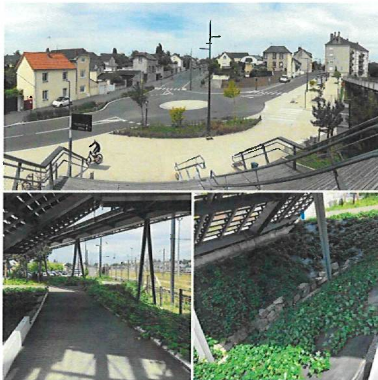
Figure 98 – Giratoire de Coubertin et aménagement paysager sous l'escalier de la passerelle
