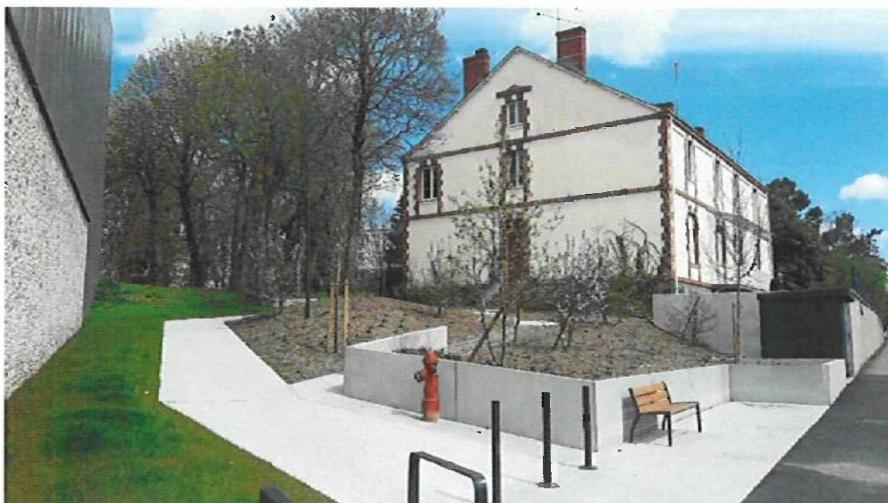
Aménagement entre l'agence Pôle Emploi et le bâtiment d'Etat-Major
