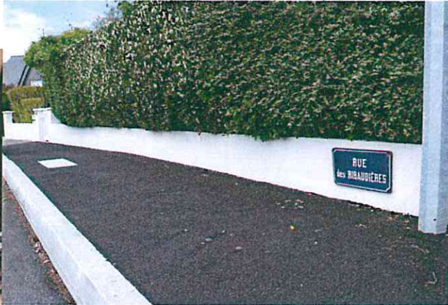
Trottoirs rue des Ribaudières
