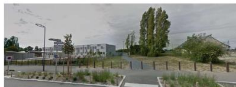
Accès au site depuis l'avenue Pierre de Coubertin
