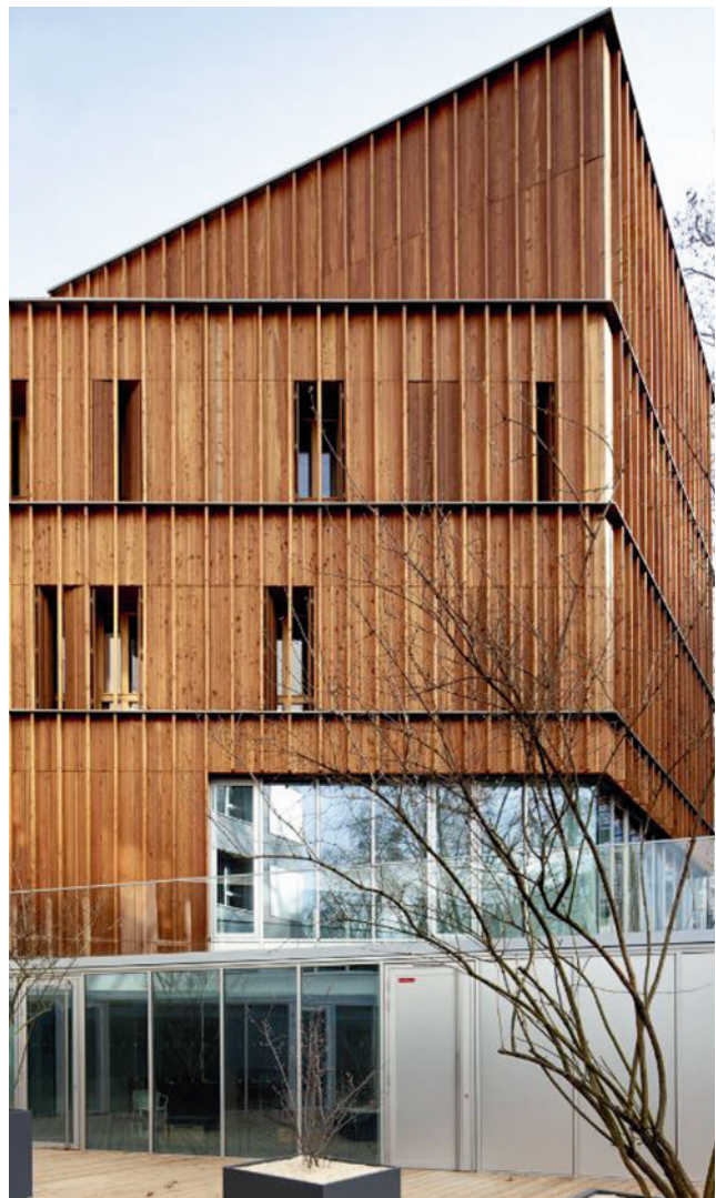
Transformation de bureaux en 139 logements étudiants en structure bois et isolation paille à Paris par Paris Habitat et NZI Architectes - @Juan Sepulveda
